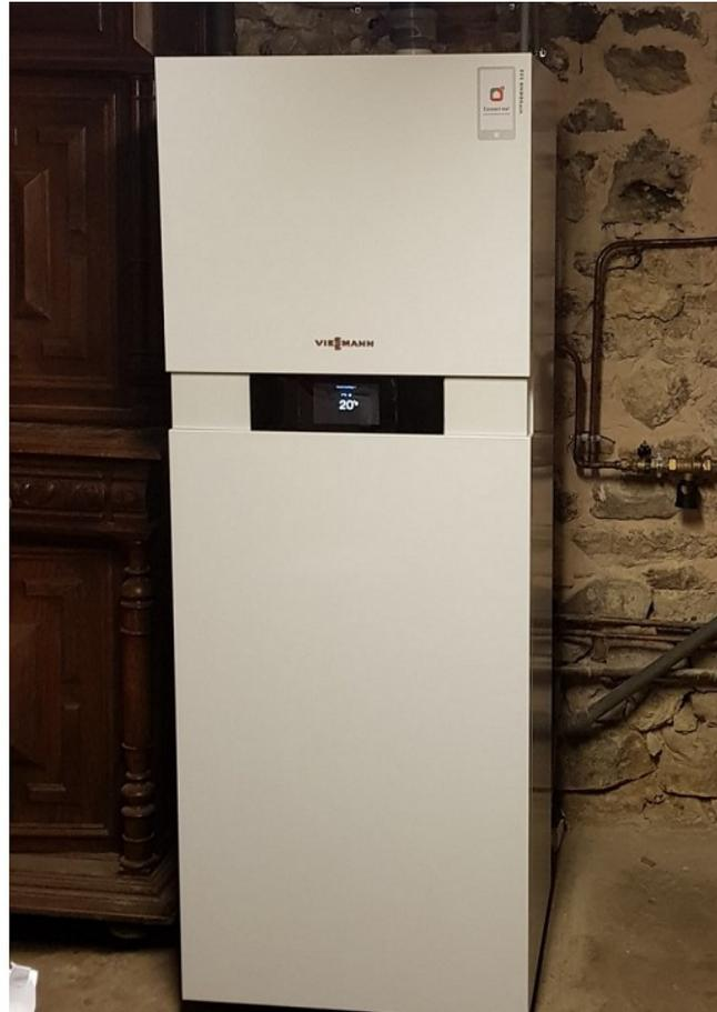
*Plombier Chauffagiste Boigneville 91 : Changement de la vieille chaudière gaz par une chaudière condensation haute performance énergétique VISSMANN VITODENS 222 F à Boigneville 91
