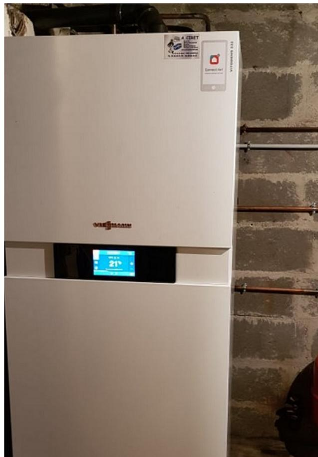
*Changement de la chaudière fioul par une chaudière gaz propane à condensation haute performance énergétique VISSMANN VITODENS 222 F, en faisant ce choix les clients ont allier réduction en consommation, aide de l'état et faible coût à l'achat. Installation située à Milly la foret 91*
