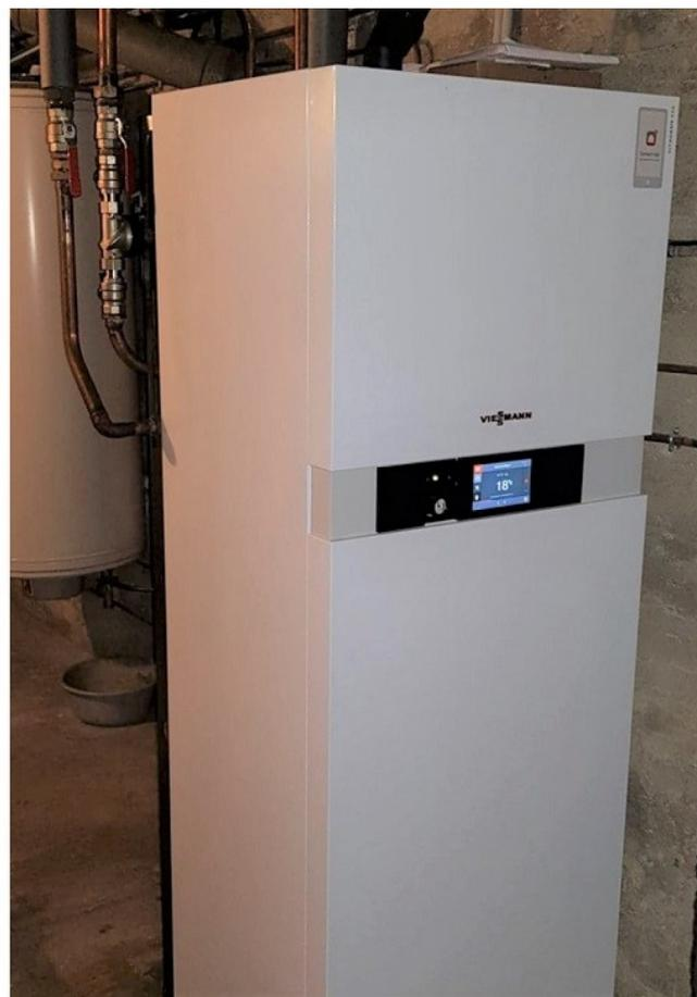
*Changement de la chaudière fioul par une chaudière gaz condensation haute performance énergétique VISSMANN VITODENS 222 F*
