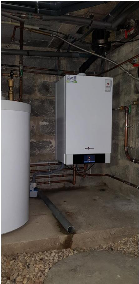
*Installation d'une chaudière gaz condensation à la place d'une chaudière gaz avec AGL*
