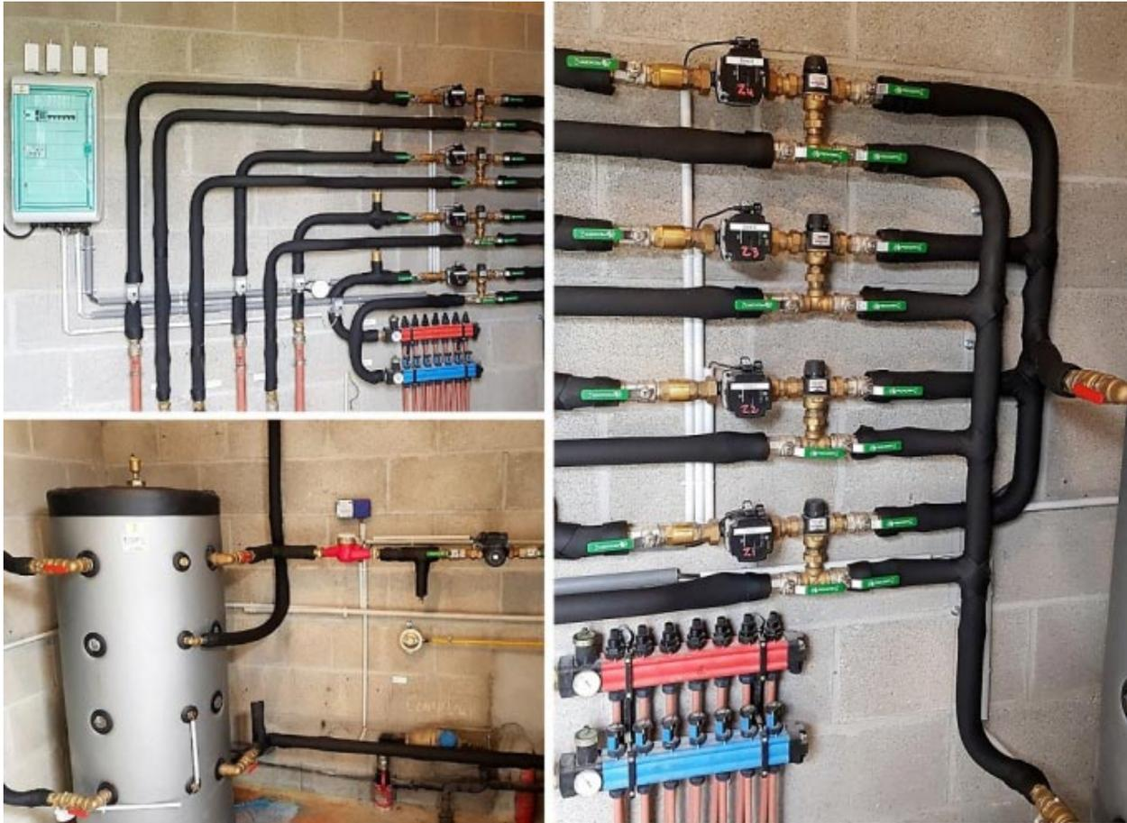
*Installation d'un système de pompe à chaleur EAU EAU LEMASSON collectif à la place de la chaudière au gaz propoane, Désmebouage de l'installation de plancher chauffant.*
